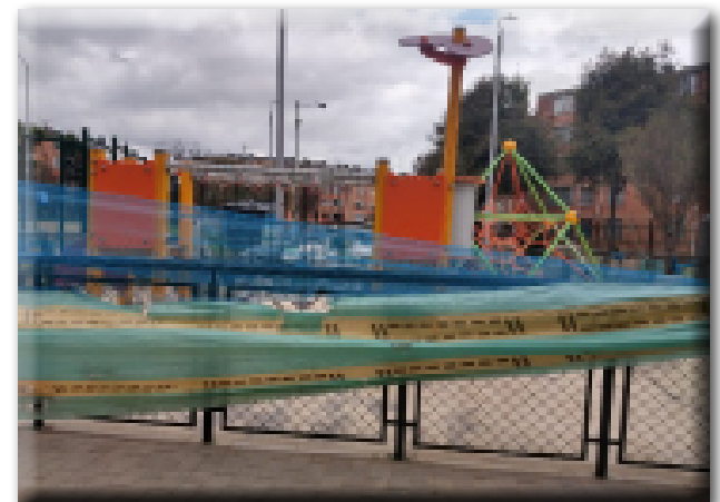
Recorrido de obras
